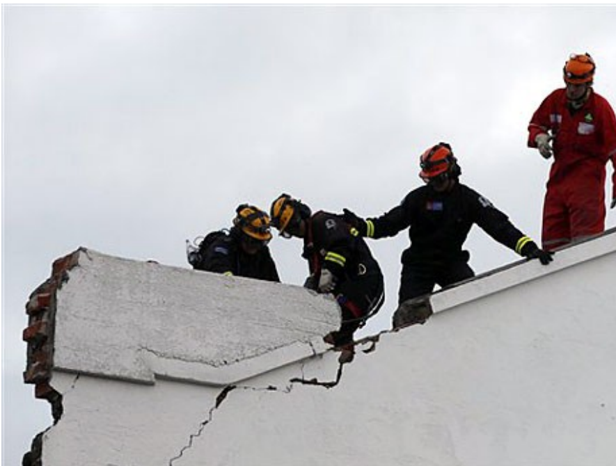
Bauarbeiter versuchen Schäden an einem Gebäude in Christchurch zu beheben. (AP)
